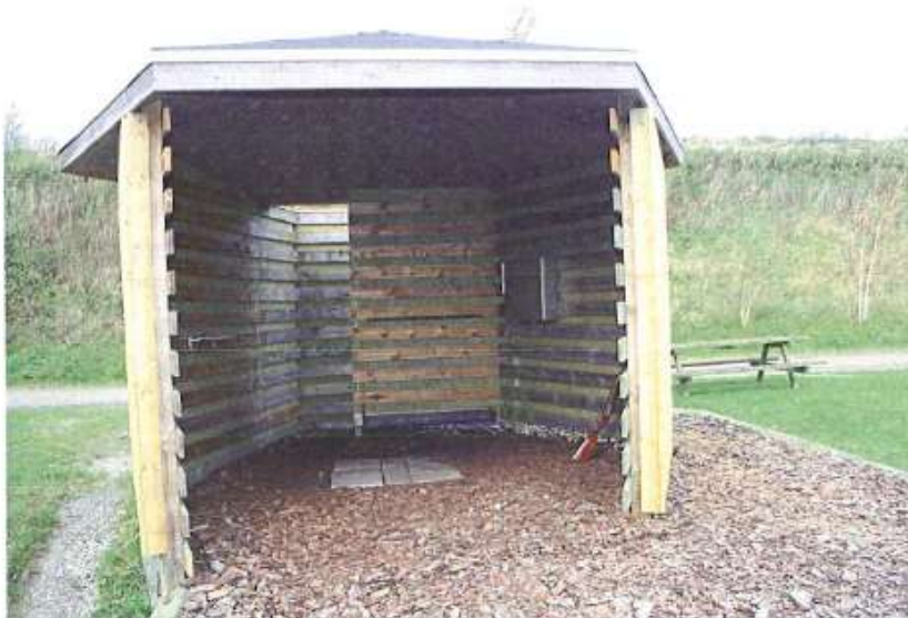
Foto nr. 4: eksempel på skydehus.
